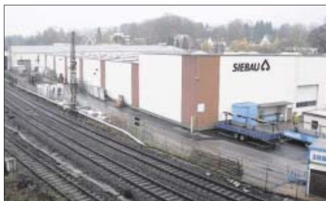
Die Firma Siebau in Kreuztal: Der nördlich der Heesstraße gelegene Teil des Werks bleibt bei Novoferm. (WR-Bild)
