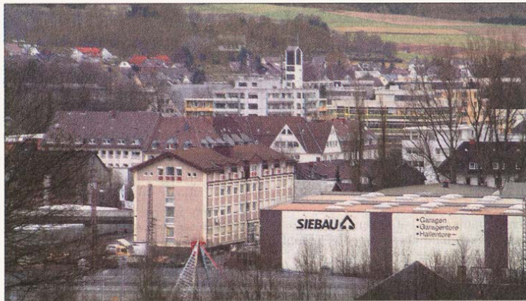
Die Firma Siebau Raumsysteme gehört nun nicht mehr zur Novoferm-Gruppe. Die 60 Arbeitsplätze und der Standort in der Kreuztaler Stadtmitte bleiben erhalten. Foto: js
