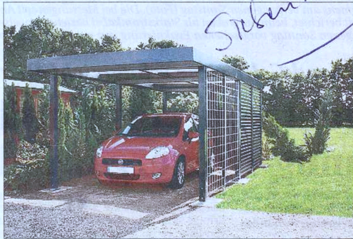
Carport aus Stahl.
